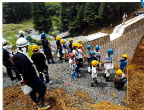
治山ダム工事現場見学会（多門院小字黒部地区）
